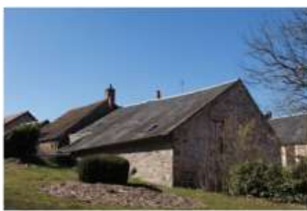
Mur en pierre de granit et toiture en tuile (Quarré-les-Tombes)
