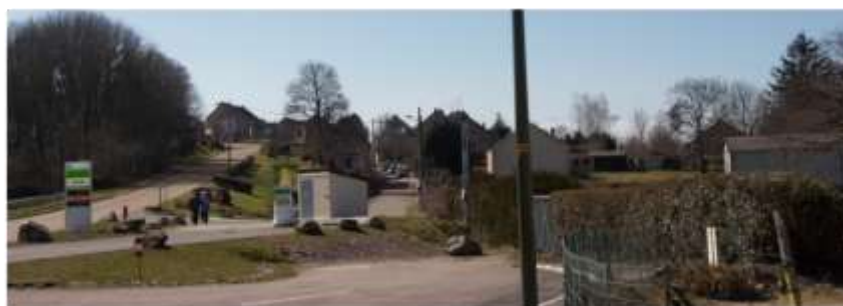
Entrée de ville peu attractive et peu lisible de Quarré-les-Tombes.
