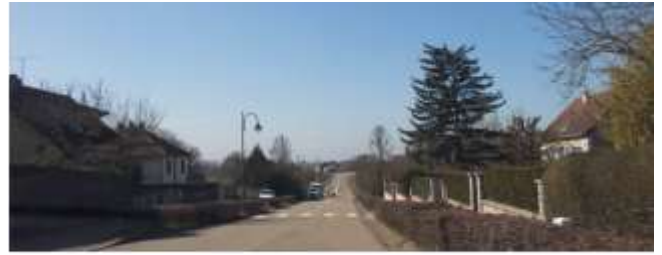
Caractère routier de la traversée de rue de Sauvigny-le-Bois.
