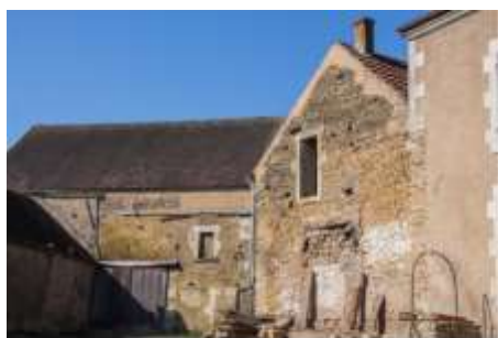
Mur en pierre sèche calcaire (Moutombié – Sainte-Colombe)
